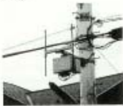
図2.26 柱の壁中に設置された アンテナ
