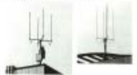
図2.28 電線杆上に設置された基地局アンテナ
