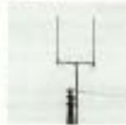
図2.27 電線杆に設置した基地局アンテナ
